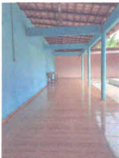
FOTO: ÁREA DE CIRCULAÇÃO 2
