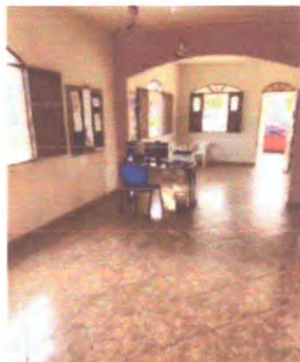
Foto 05: Área de circulação
