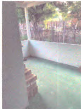
FOTO: ÁREA DE CIRCULAÇÃO
