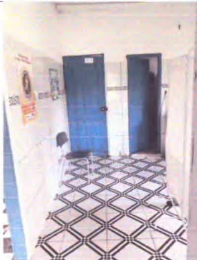
FOTO: ÁREA DE CIRCULAÇÃO 1
